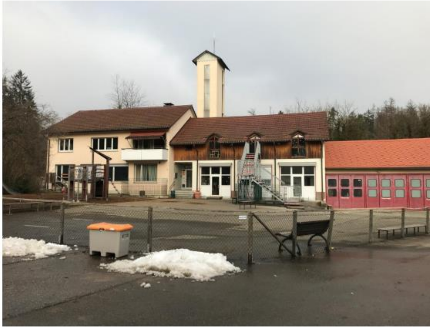
Gebäude Brunnenmatt 4 vor der Renovierung und Neuausstattung.
