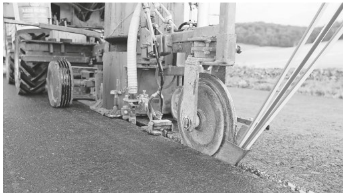
Stufenschleifverfahren: Ein schmaler Schlitz wird in die Asphaltdecke geschliffen (Foto: Fiber Europe)
