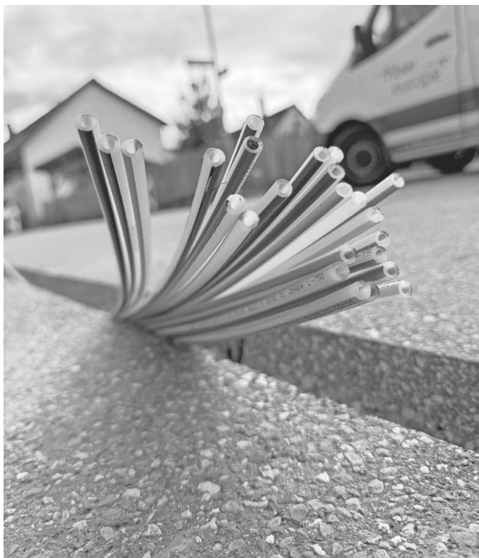
Im Pilotprojekt Stadenhausen hat Stiegeler erstmalig das innovative Stufenschleifverfahren eingesetzt
